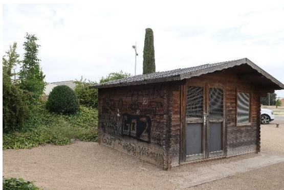
Caseta equip d'impulsió xarxa aigua de pou.
