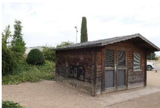
Caseta equip d'impulsió xarxa aigua de pou.
